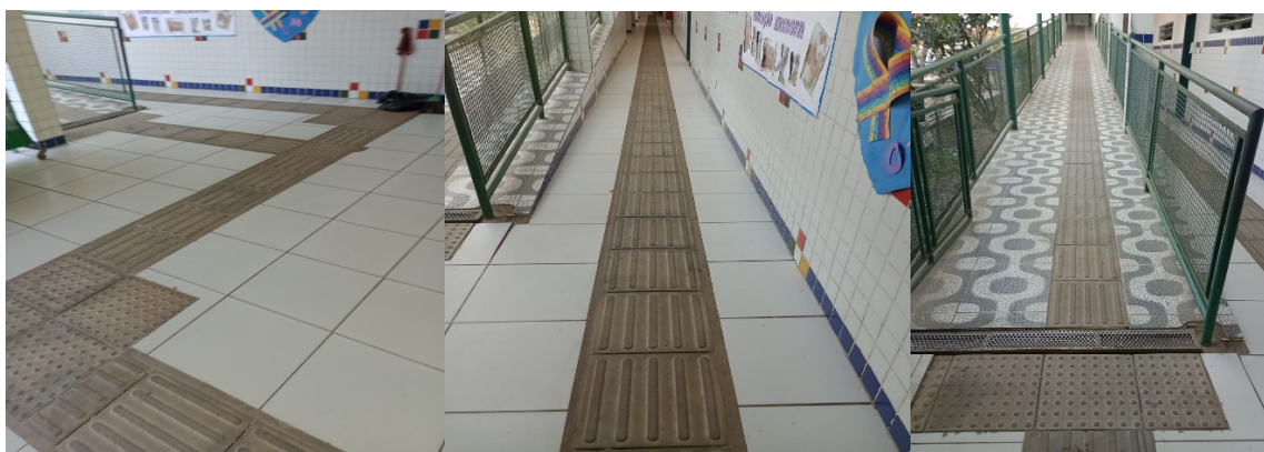
Figuras 2, 3 e 4. Piso tátil de acessibilidade para deficientes visuais.
