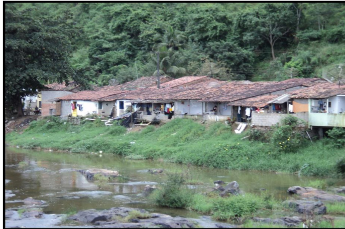
Figura 7 – Moradias instaladas em área de risco fluvial
