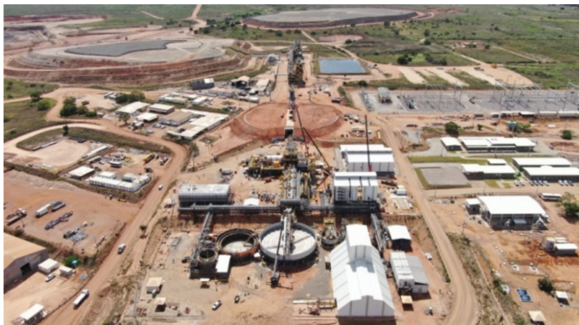
Figura 2. Infraestrutura montada pela Mineradora Vale verde no município Craibas/AL
