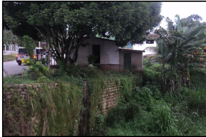
Figura 3 – Vista parcial de ponto comercial instalado às margens do rio
