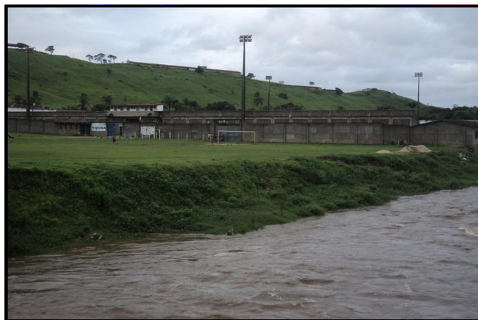
Figura 4 – Estádio de futebol construído na planície fluvial do rio
