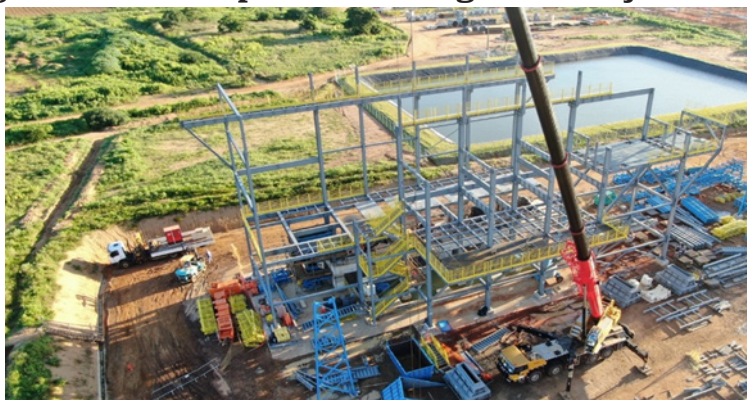
Figura 3. Obras na planta de britagem no Projeto Serrote
