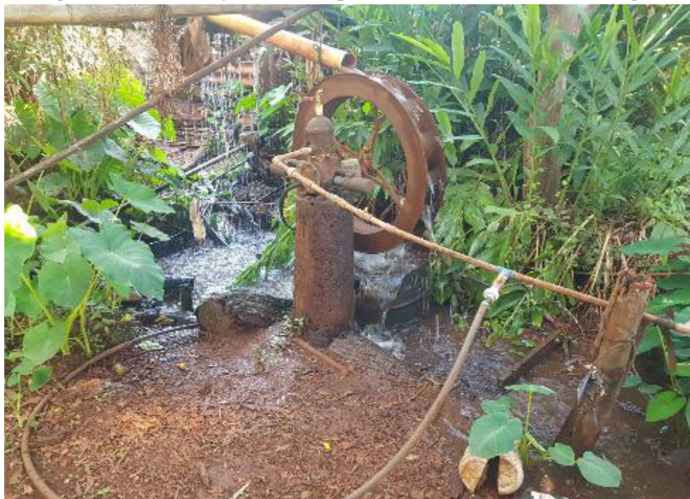
Figura 4 - Intervenção no canal para funcionamento da roda d'água.
