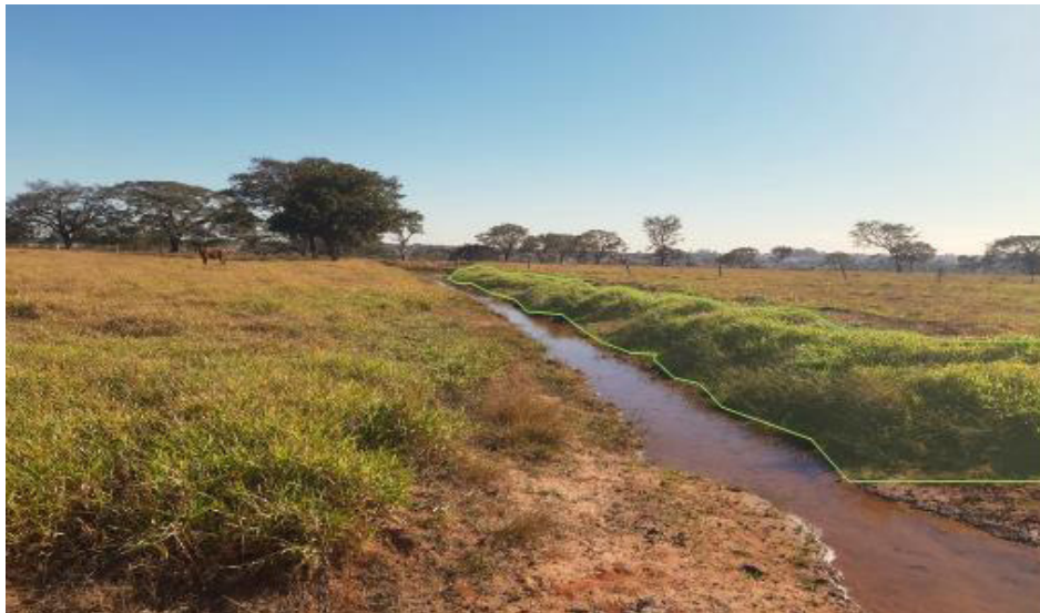
Figura 11- Presença de dique lateral atuando no escoamento superficial.
