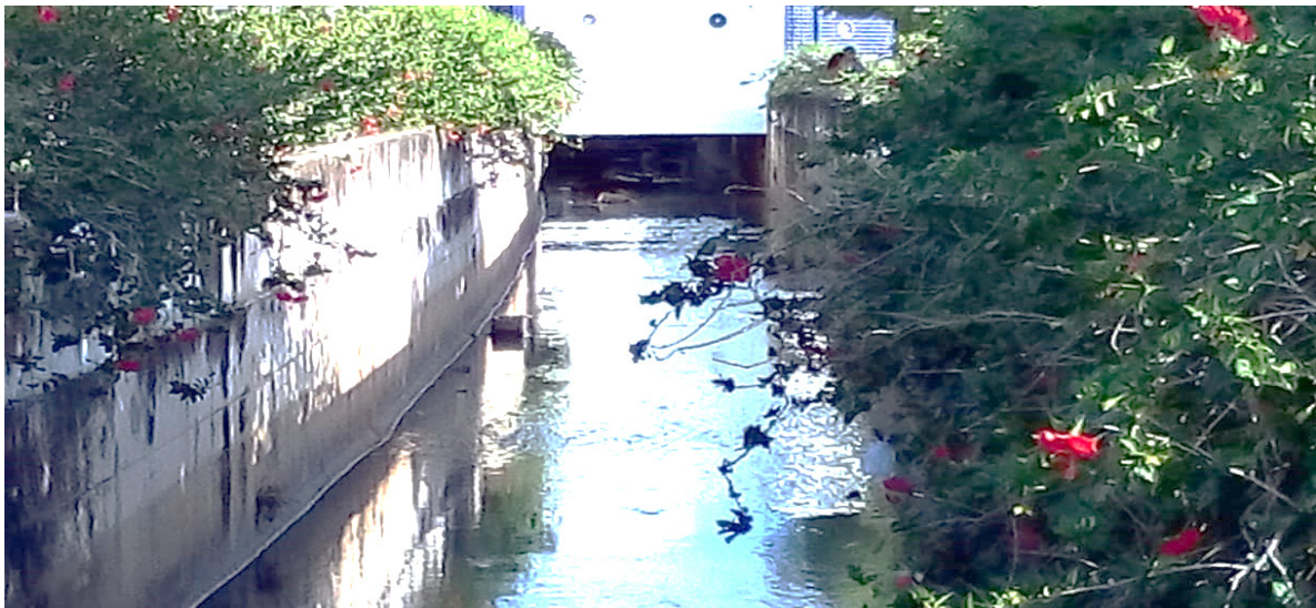
Figura 6. Canal por onde passa um trecho do riacho Piauí, localizado no Parque Ceci Cunha, com a presença de muito lixo em seu interior destacado pelos círculos na foto.
