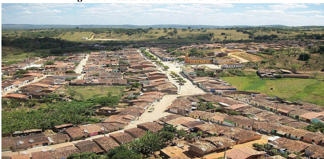
Figura 1. Vista aérea do distrito Rainha Isabel-PE.
