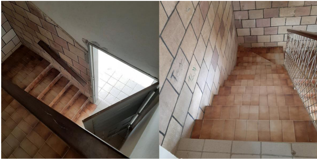
Foto 1: Escadarias de acesso à biblioteca
